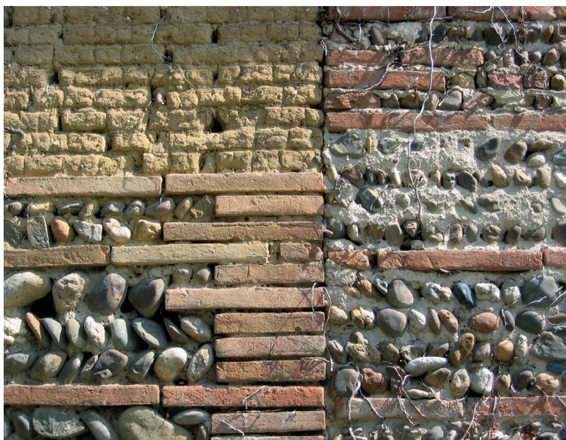
**Appareillage** de matériaux de deux constructions voisines. Murs composés de terre crue, terre cuite et galets de rivières en épis, hourdés d'un mortier de chaux.
