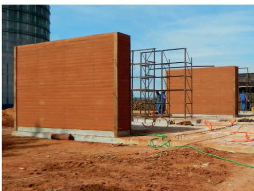
**Les murs en *taipa de pilão*** montés dans le système de coffrage utilisant des structures métalliques développées par l'agence Taipal
