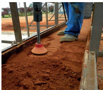
**L'état actuel du matériel développé par Taipal pour une production mécanisée sur le chantier :** compacteur à air comprimé, cadres servant au coffrage et mélangeur ayant été progressivement améliorés au cours de plusieurs versions successives.
