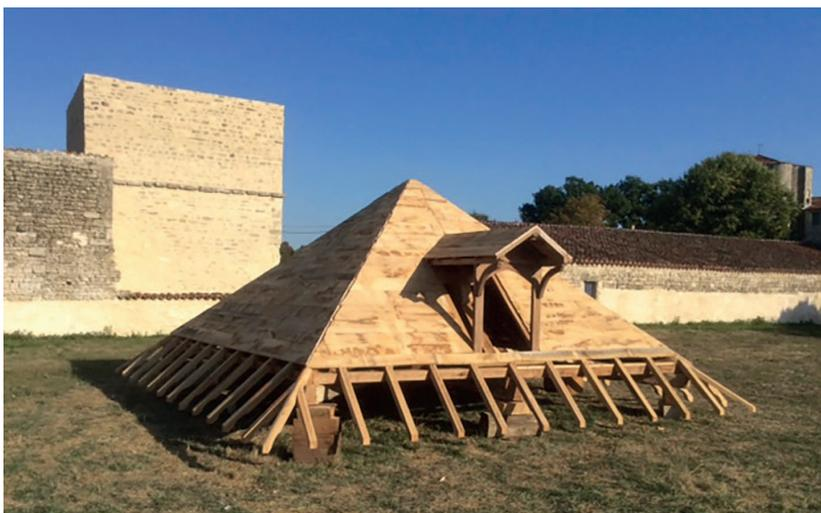
**Toiture avant pose.** Au deuxième plan, les murs de moellons et chaux flambant neuf attendent leur charpente à quatre pentes avec lucarne.
