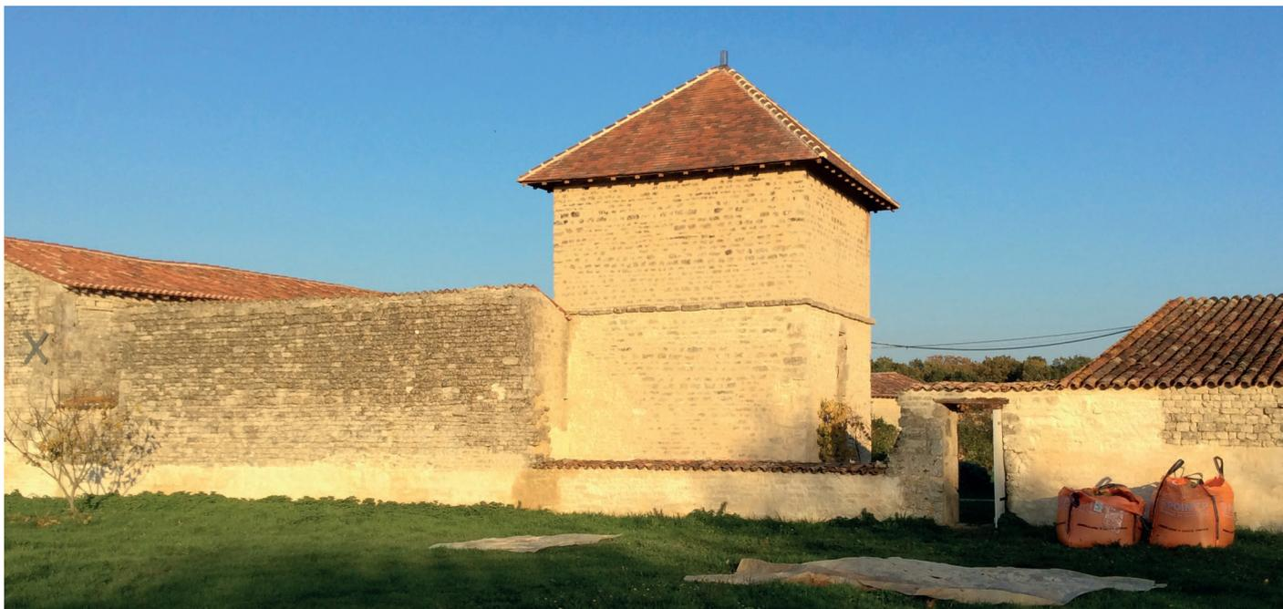
**Le bel ouvrage sous les rayons rasants au premier jour de sa nouvelle vie.** La couverture en terre cuite et son faitage avec embarrure sont coiffés d'un poinçon en zinc.
