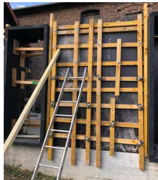
Mise en place du coffrage sur un bon soubassement : la terre doit être protégée de l'humidité ascendante.
