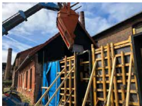
Coulage de la terre dans les banches.
