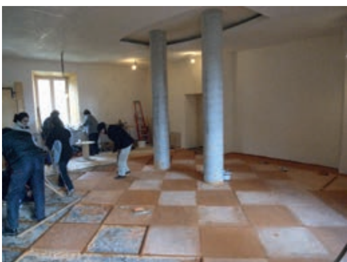
Le 11 octobre 2019 à la chapelle de Beaumont, une quinzaine de personnes ont pu s'initier à la réalisation d'un sol en plâtre, sous la conduite d'Olivier Duport, dans le cadre d'une demi-journée organisée par l'Université Rurale Montagnarde.
