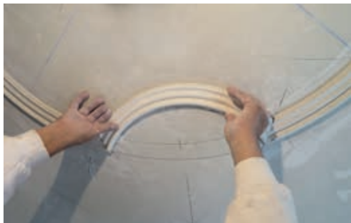
... et la pose de moulures.
