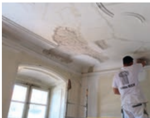
Le plafond est ici refait aux endroits dégradés.
