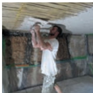
Dans une autre pièce, le plafond est entièrement fabriqué par le plâtrier qui forme Nicolas au métier !
