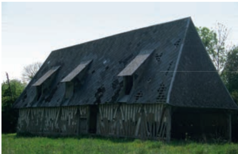
Enduit plâtre sur torchis, à Saint-Victor-d'Épine (Eure).
