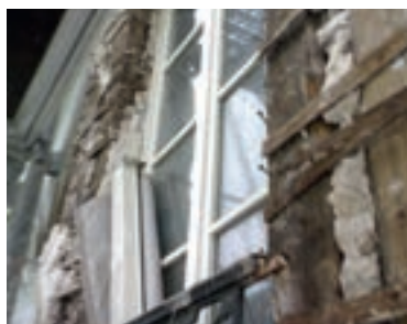
Pan de bois destiné à être enduit au plâtre , façade sur rue - Paris 5 e (Seine).
