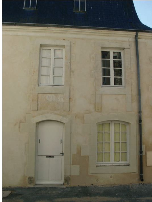
Les remontées capillaires mouillent le bas du mur.
