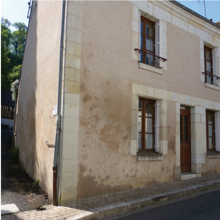
Enduit à la chaux , mais encore trop hydraulique.
